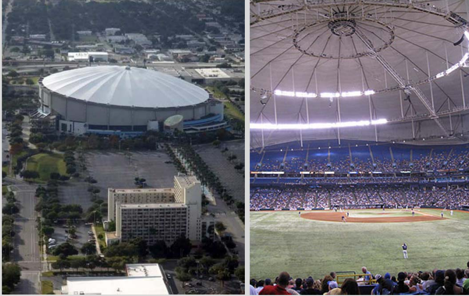
Kupola sa kabelima - Tropicana Dome Stadium, Florida (1990)
